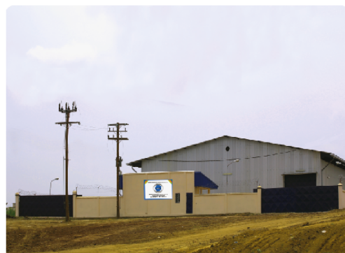
Magasin de Stockage CNCC de Douala Bassa - Région du Littoral CNSC Douala Bassa Cargo Warehouse - Littoral Region
