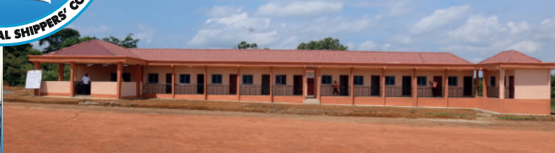
Centre de vie CNCC de GAROUA-BOULAÏ dans la Région de l'EST
