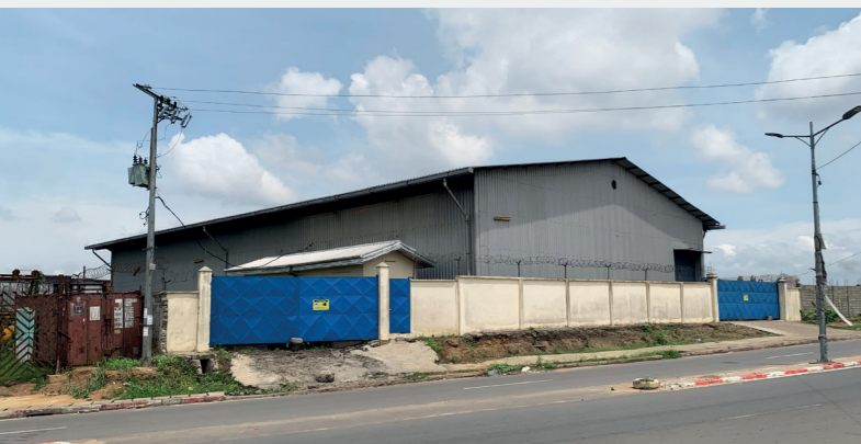
Magasin de stockage de DOUALA-BASSA dans la Région du Littoral
